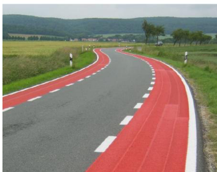
Abb. 36-37: Vorher-Nachher-Bilder zu Teststrecke LK Nordheim, DTV 1.100 Kfz/Tag, Fahrbahnbreite 6,00 m
