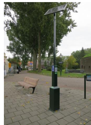
Abb. 45: Solarbetriebene Ladesäule mit Steckdosen zur kostenfreien Nutzung für Pedelecs und Rollstühle
